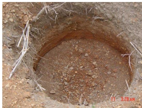
Hình 13: Đào hố bằng máy
